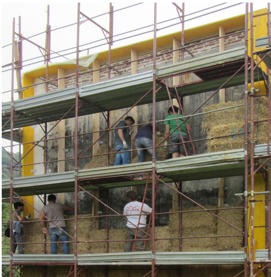
Realizzazione in autocostruzione dell'isolamento con balle di paglia RH-P sulla sede Ricehouse
